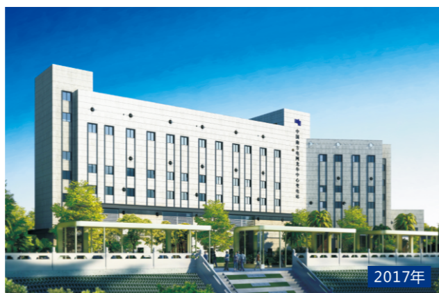
深圳龙华变电站
