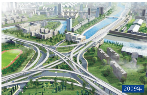
上海虹桥枢纽工程
