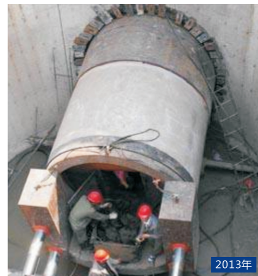
运河饮水工程顶管隧道
