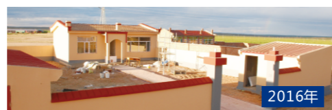
内蒙古牧民新居政府改造工程
