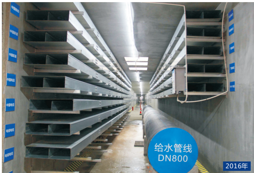
嘉兴科技城地下综合管廊
