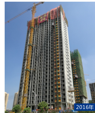
长沙万家园保障性安居工程
