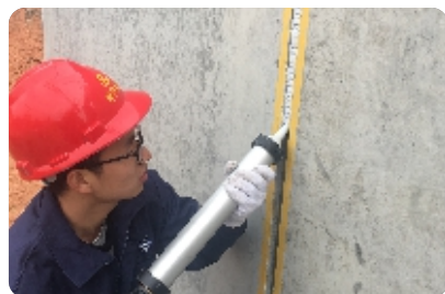
外墙板拼缝
