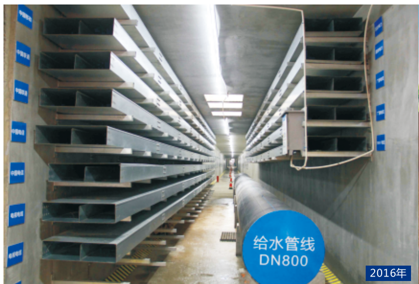
嘉兴科技城地下综合管廊
