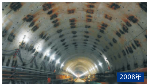
崇明岛越江隧道
