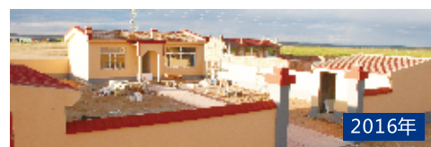
内蒙古牧民新居政府改造工程
