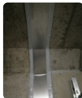
预制管廊拼缝
