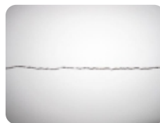
建筑裂缝修补 力键360UV、力键8230
