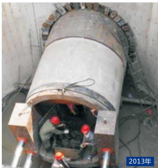
运河饮水工程顶管隧道
