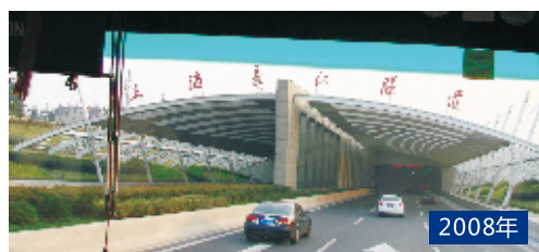
上海长江隧道
